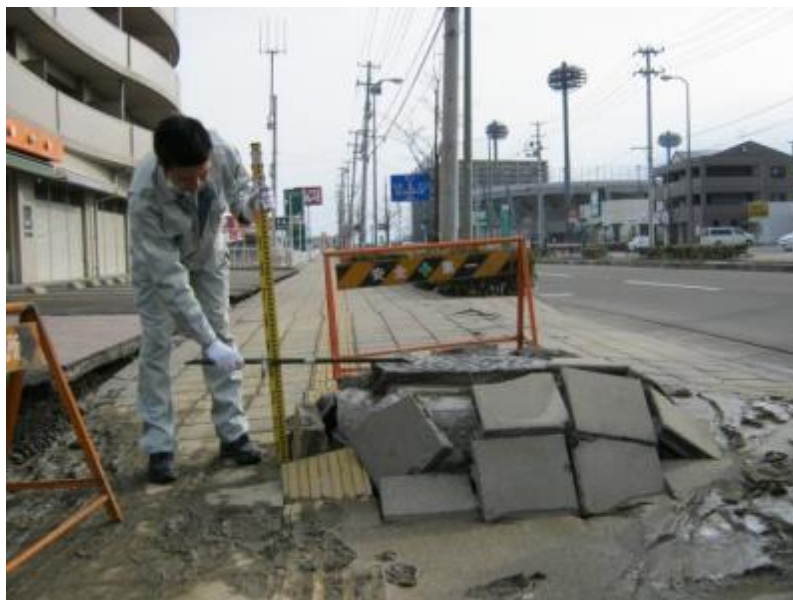
液状化による人孔の浮上
