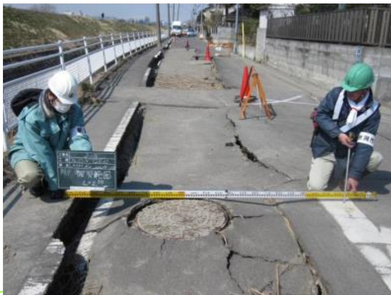
管きよ工事掘り山の陥没
