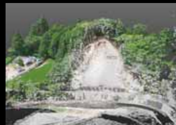
被災後の3次元点群データ
