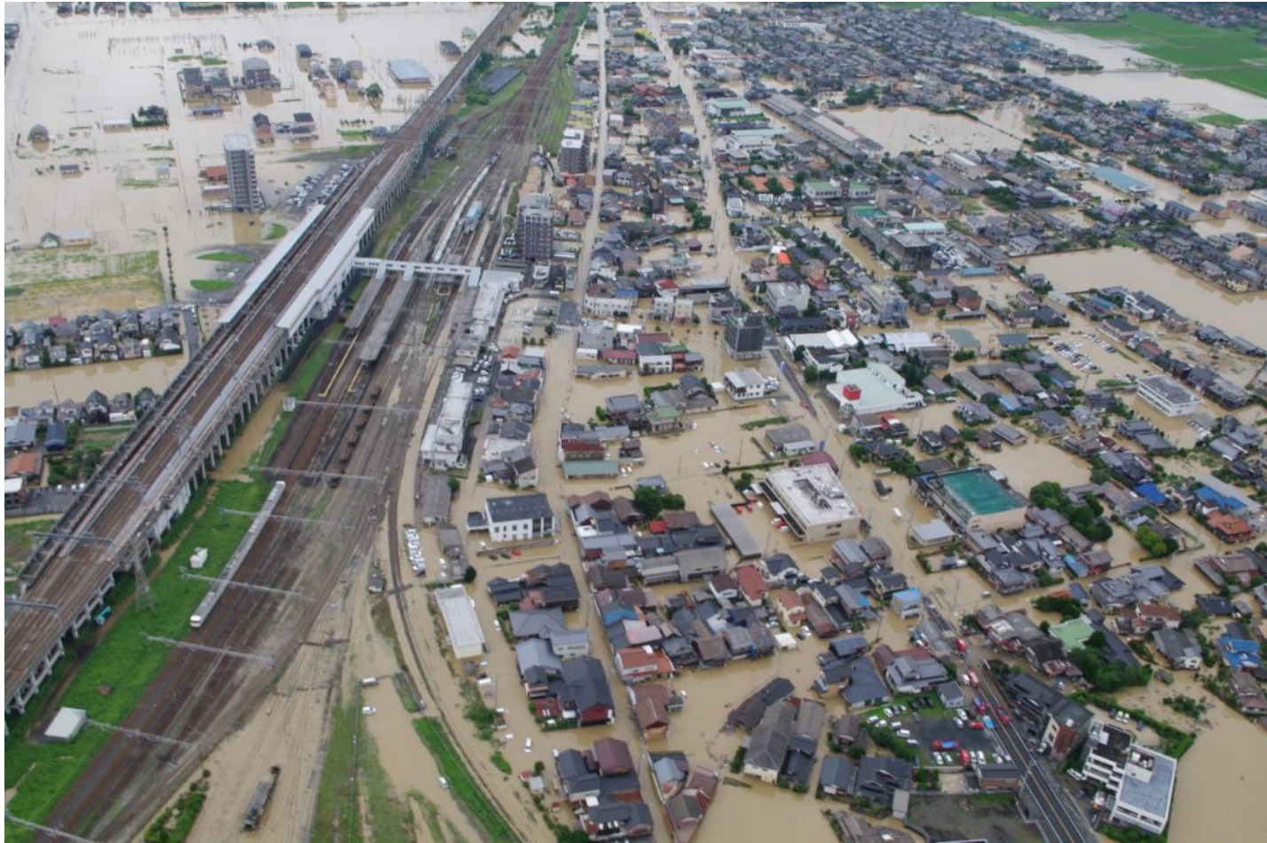
2010年7月10日 山陽小野田市 厚狭地区水害
