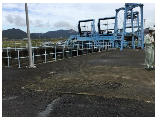
防災設備（ポンプ場）
