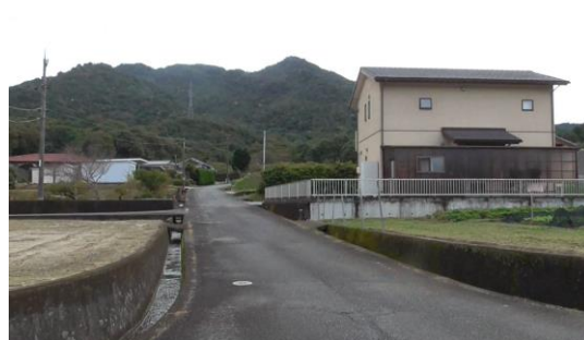
土砂災害警戒区域内のふたのない側溝
