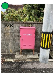
ホース格納庫
