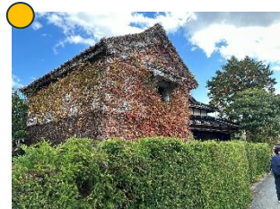
(地震時危険) 瓦倒壊、火災
